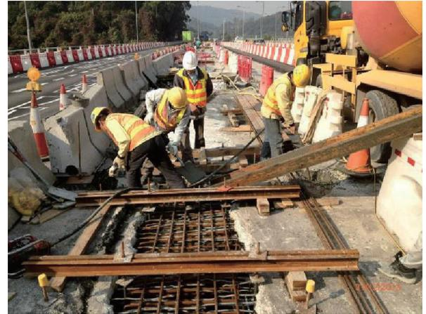
圖15. 澆灌混凝土中的拼接板和加強樑
