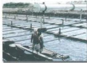
圖 18. 鋼拉桿預先組裝法 (GK 施工方法)
