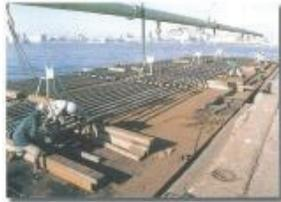
將預先組裝好的鋼拉桿用我公司開發的「長大吊具」裝於工作船，運抵施工現場。
